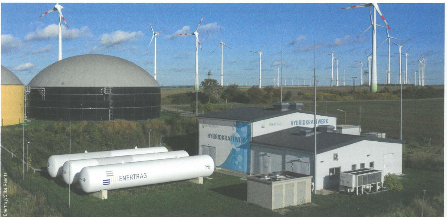
Dass Wasserstoff aus Windstromelektrolyse technisch längst funktioniert, beweist seit zehn Jahren das „Hybridkraftwerk Prenzlau“ von Enertrag mit einem 500-kW-Elektrolyseur, einer Tonne Wasserstoff-Speicherkapazität und zwei Blockheizkraftwerken zur Stromerzeugung aus dem gespeicherten Wasserstoff.
